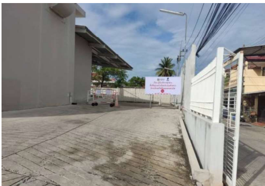
รูปที่ 2-7 รั้วของโครงการสามารถป้องกันการพังทลายของดินถมสู่พื้นที่ข้างเคียงได้
