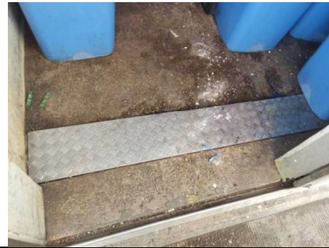
รูปที่ 2-11 รางรวบรวมน้ำเสียจากห้องพักมูลฝอยเข้าสู่ระบบบำบัดน้ำเสีย
