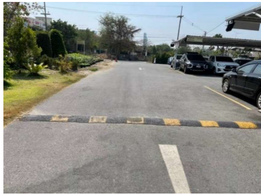
รูปที่ 2-2 สันนุนชะลอความเร็วรถบริเวณทางเข้า-ออก โครงการและภายในโครงการ
