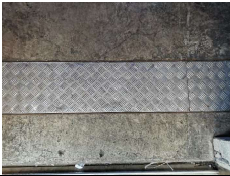
รูปที่ 2-11 รางรวบรวมน้ำเสียจากห้องพักมูลฝอยเข้าสู่ระบบบำบัดน้ำเสีย
